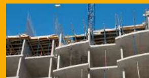
FUNDICIÓN IN-SITU Y PREFABRICADOS DE CONCRETO
