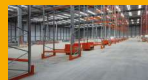
LOSAS DE CONCRETO
