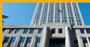
REPARACIÓN Y PROTECCIÓN
