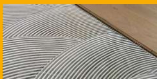
INSTALACIÓN DE PISOS
