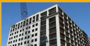
REPARACIÓN DE CONCRETO
